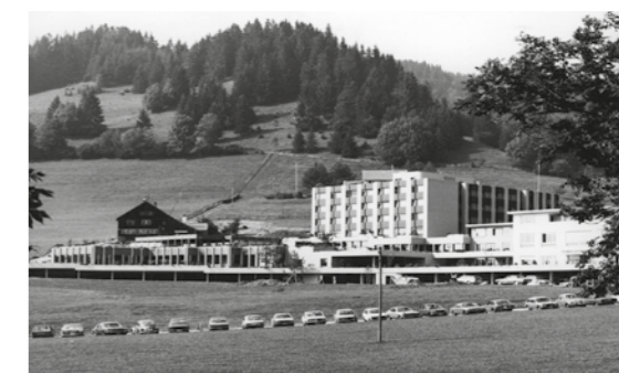
... das 1977 fertiggestellt wurde.
